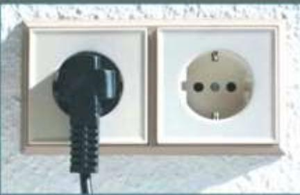
Електронагрівальні прилади, телевізори, радіоприймачі та інші побутові електроприлади і апаратуру належить вимкнути в електромережу тільки за допомогою справних штепсельних з'єднань та електророзеток заводського виготовлення
