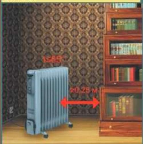
Відстань від приладів електроопалення до горючих матеріалів і будівельних конструкцій має становити не менше 0,25м. Температура зовнішньої поверхні електроопалювальних приладів у найбільш нагрітому місці в нормальному режимі роботи не повинна перевищувати 85°C
